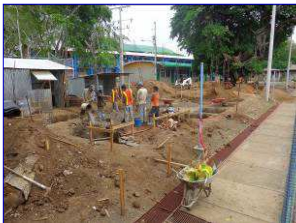
Panorámica del proyecto, donde se aprecia la ejecución de las obras de fundaciones.
