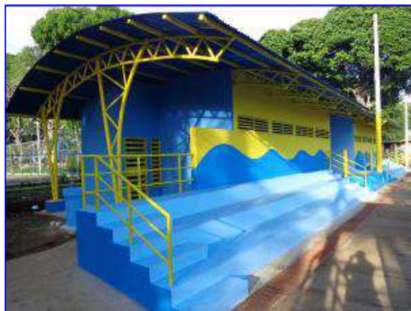
Fachada principal del edificio de vestidores de Volibol de Playa, donde se observa la gradería para público.
