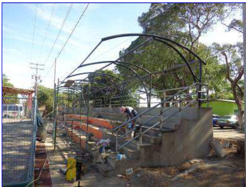
Vista panorámica de la ampliación de gradería costado Este, donde se aprecia la instalación de estructura metálica de techo, acabados en graderías.
