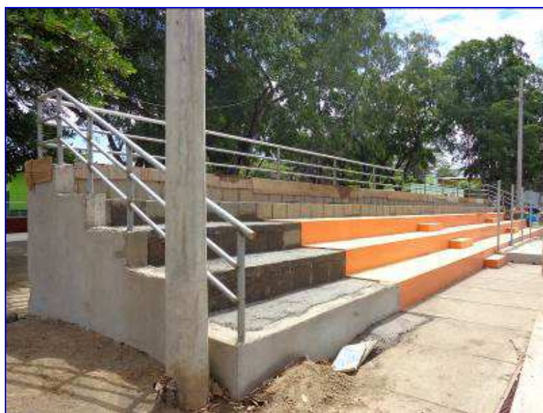
Vista panorámica de la ampliación de gradería costado Este.
