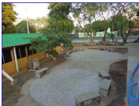
Vista panorámica de las obras exteriores.
