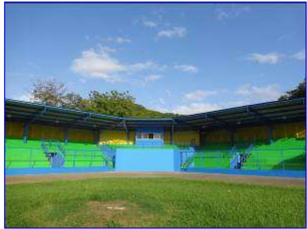
Vista panorámica de las graderías, área de cabina y palco VIP ya finalizados.
