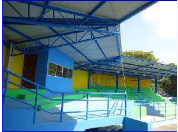
Vista panorámica del área de cabina, palco VIP y graderías costado norte.
