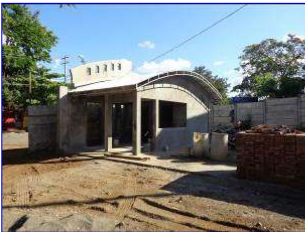
Vista panorámica de la caseta de vigilancia en el Gimnasio de Gimnasia.
