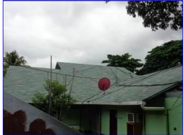
Apreciar el reemplazo de la cubierta de techo del edificio principal del IND (dirección ejecutiva).
