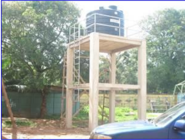
Vista panorámica de la construcción de la torre metálica e instalación del tanque de agua.
