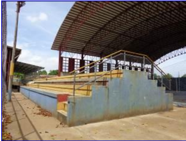
Vista panorámica del área donde se construirá graderías sin proyecto.
