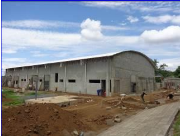
Vista panorámica del edificio de Gimnasio de Gimnasia, donde se aprecia la construcción de obras exteriores (talud de conformación, andenes de conexión).
