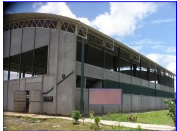
Vista panorámica del Gimnasio donde se aprecia la instalación de verjas de protección metálicas (derecha) y cerramiento de durock (a la izquierda).
