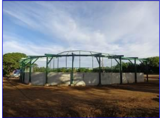
Vista panorámica de la construcción de estructura metálica de techo en el área de gradería del back stop.
