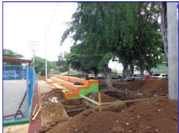
Vista panorámica de gradería costado este donde se aprecia la ejecución de las excavaciones para fundaciones.
