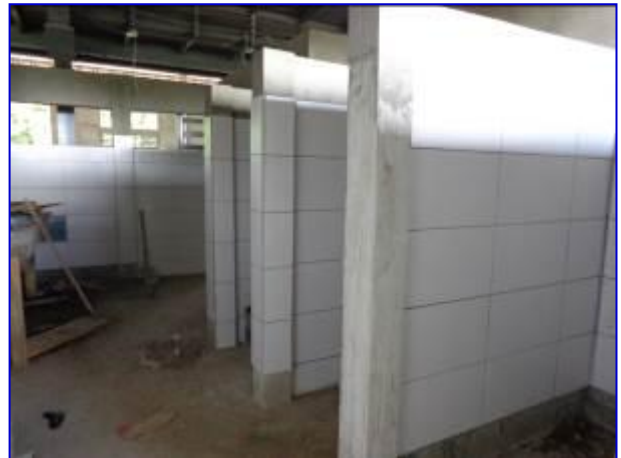
Vista interna del área de batería sanitaria donde se aprecia el enchape de azulejos en paredes.
