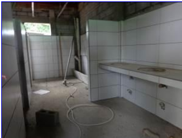
Vista interna de batería sanitaria hombres, donde se aprecia la instalación de azulejos en paredes, urinario y top de lavamanos.
