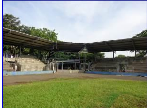
Vista panorámica del área de gradería, donde se puede apreciar la cubierta de techo y construcción de graderías.
