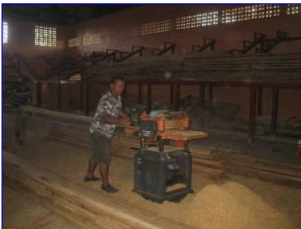
Apreciar en ambas fotografías el suministro y cepillado de madera para la conformación de la huella de la gradería.
