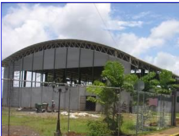
Vista panorámica del Gimnasio donde se observa la instalación de cerca perimetral de malla ciclón.
