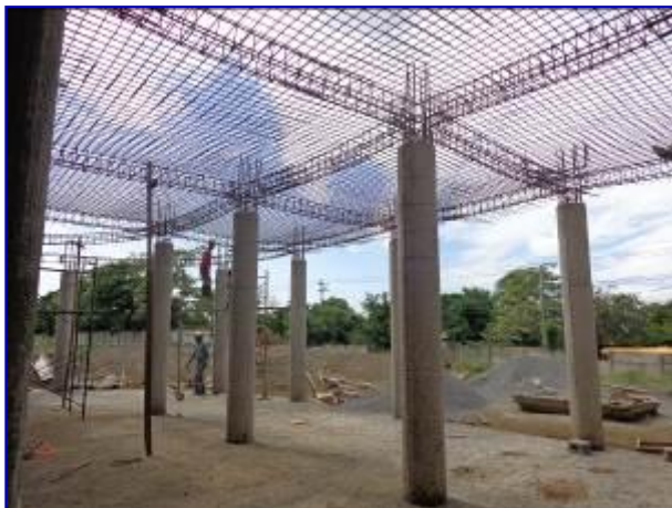
Vista panorámica de la estructura de concreto del área de acceso principal del Gimnasio de Gimnasia.
