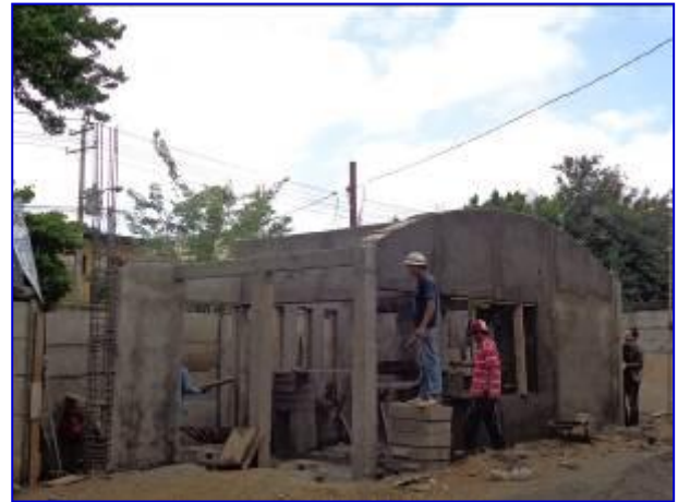
Vista panorámica de la construcción de la caseta de acceso.
