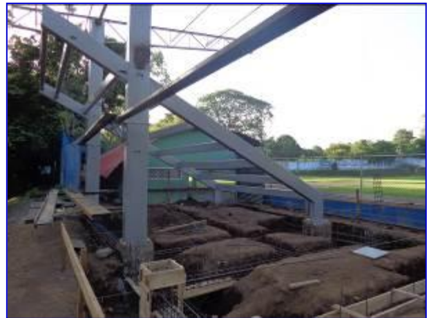
Vista panorámica del área de gradería costado norte, donde se puede apreciar la ejecución de las etapas de fundaciones e instalación de la estructura principal de graderías.
