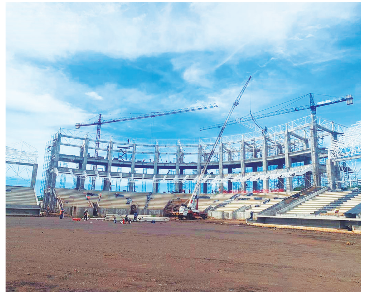
Vista panorámica de la instalación de cerchas metálicas de cubierta de techo en el cuerpo central.
