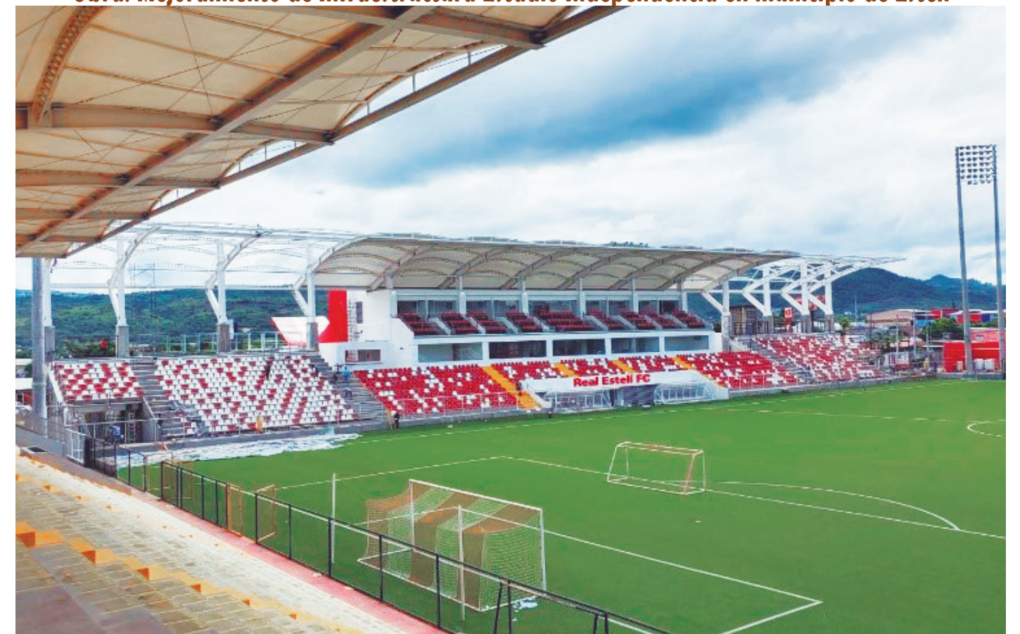
Vista panorámica de la gradería costado Este, donde se aprecian la instalación de las butacas, estructura metálica de techo, en espera de la cubierta de techo.
